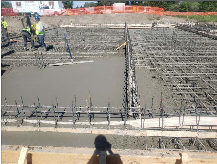
Bottom slab concrete pour underway – trowel finishing.
