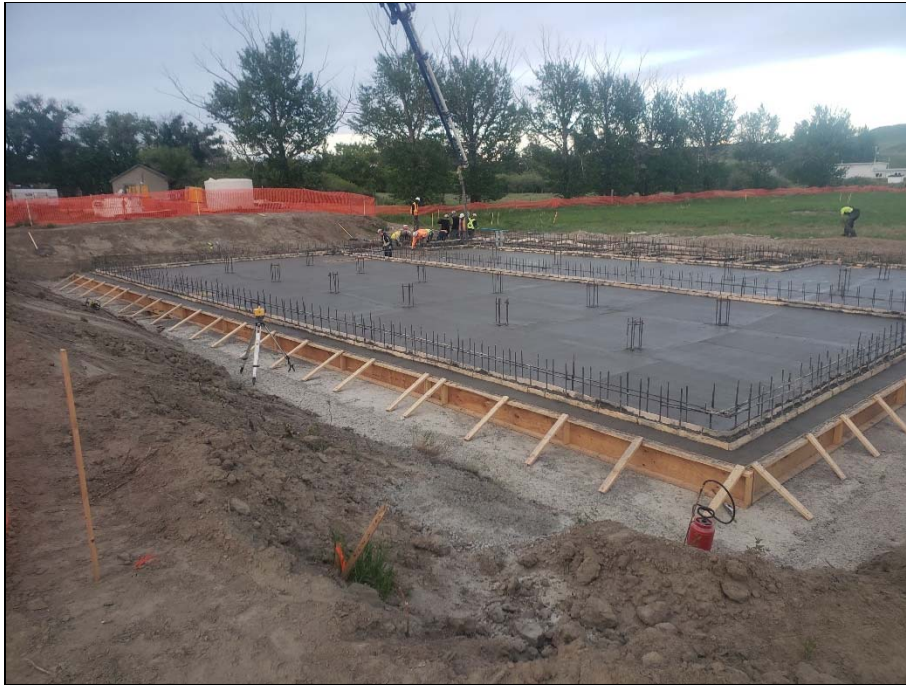
Bottom slab concrete pour – completion.
